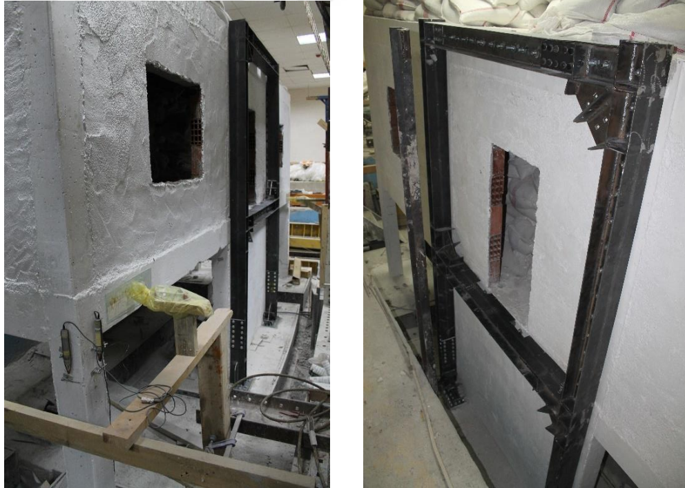
Şekil 3.16 BEÇÇ'lerin monte edileceği çerçevelerin tamamlanmış montajı a) Hidrolik pistona göre binanın sağ tarafı b) Hidrolik pistona göre binanın sol tarafı
