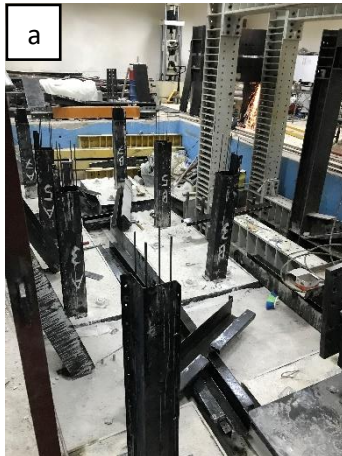
Şekil 3.13 Kalıp kurulum aşamaları a) Kolon kalıpları b) Kiriş kalıpları c) Döşeme kalıpları ve kalıp kurulumunun tamamlanması
