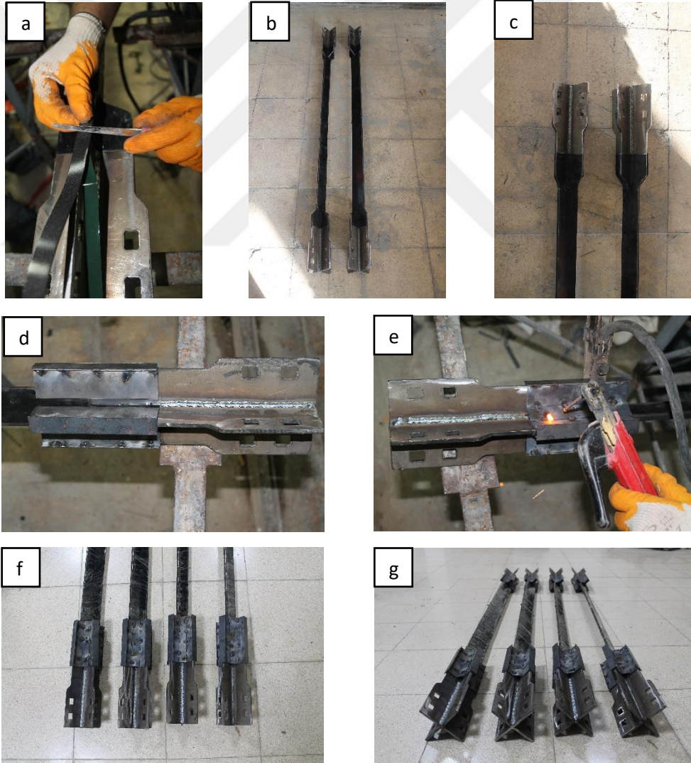
Şekil 3.21 BEÇÇ eleman izolasyon ve kızak sistemi yapımı a) İzolasyon malzemesinin ÇE’na yapıştırılması b) ve c) İzolasyon malzemesiyle kaplanmış ÇE’ler d) ve e) Kızak sistemin yapım aşamaları f) ve g) Kızak sisteminin imalatının tamamlanmış hali
