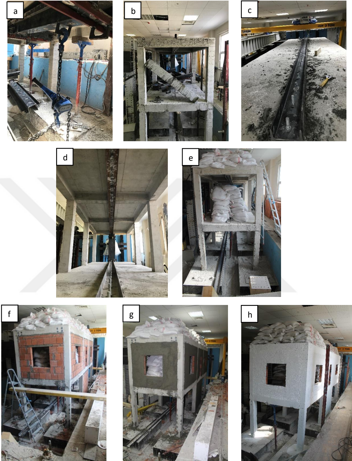
Şekil 3.15 Betonarme sistemin imalat aşamaları a) Kalıpların söküm işlemi b) Kalıpların söküm işlemi c) Deney esnasında hidrolik pistondan uygulanan kuvvetin kat döşemesine eşit olarak aktarılmasını sağlayarak rijit diyafram etkisi veren U profillerin döşemeyle adanansını sağlaması için tamir harcı uygulaması d) U profiller e) Temsili yük olarak her biri 25kg olan kat başına 300şer çuvalın yüklenmesi f) Tuğla duvar örülme aşaması g) Sıva aşaması h) Badana sonrası deney elamanının betonarme kısmının nihai hali
