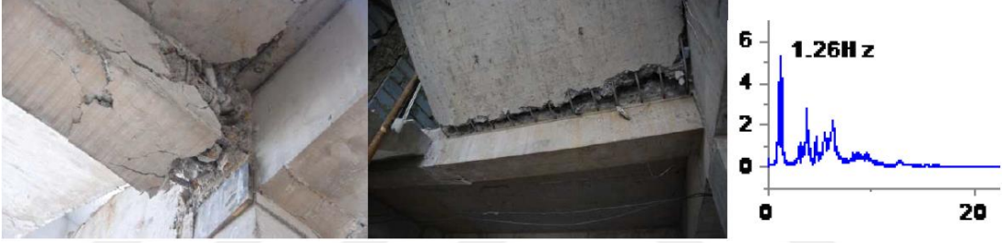
Şekil 2.19 Beş katlı hastane binası ve ölçülen frekans değerleri (Yang 2013)
