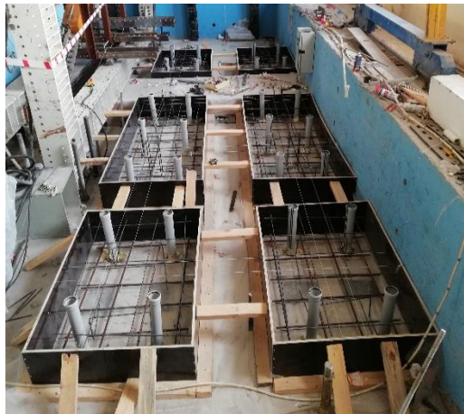
Şekil 3.9 Laboratuvar koşullarına göre boyutlandırılmış temellerin imalatı
