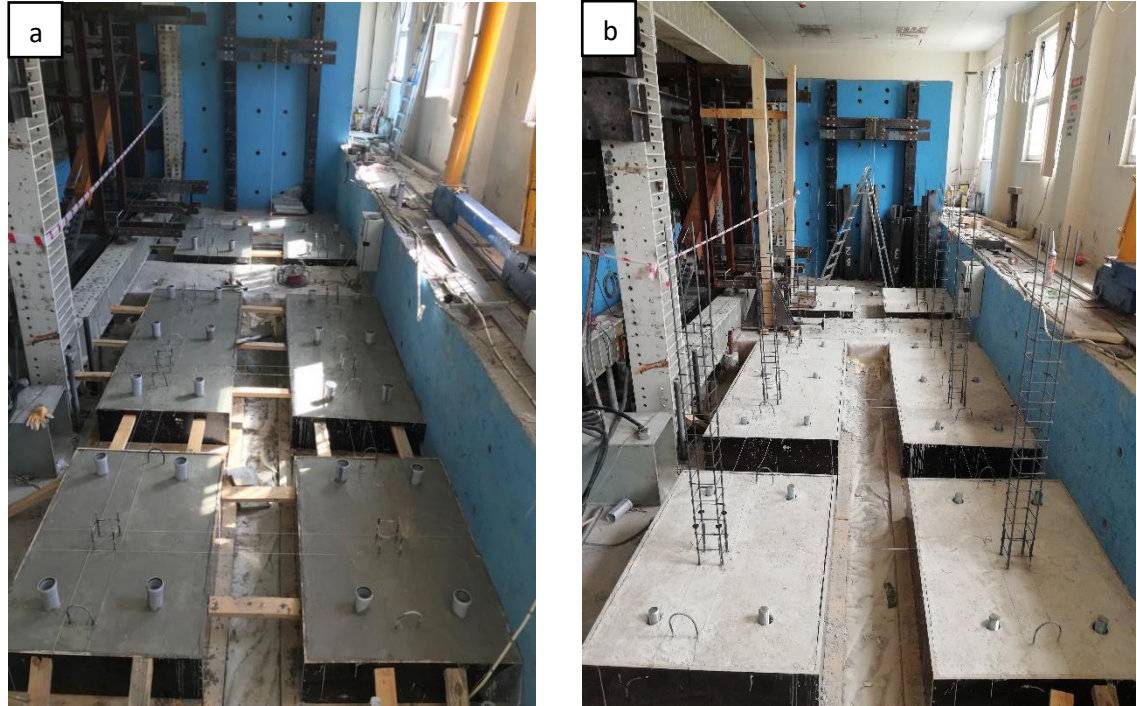
Şekil 3.11 Temel betonu dökümü sonrası a) Yeni dökülmüş beton ve kolon filizleri b) Filizlere bağlanmış kolon donatıları
