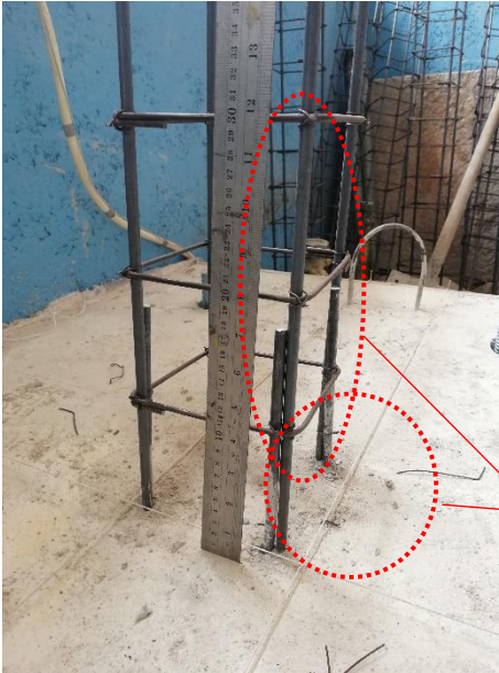
Şekil 3.6a ve Şekil 3.6b Yetersiz sayı ve nitelikteki etriyeler
