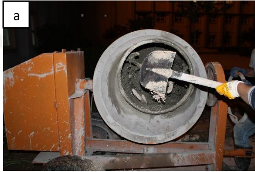
Şekil 3.12 Kat betonlarının hazırlanması a) 0,25 m 3 kapasiteli betonyer b) Hazırlanan betonun hem istenilen işçilik kusurlarının oluşması hem de laboratuvar imkanları doğrultusunda elle dökülmesi
