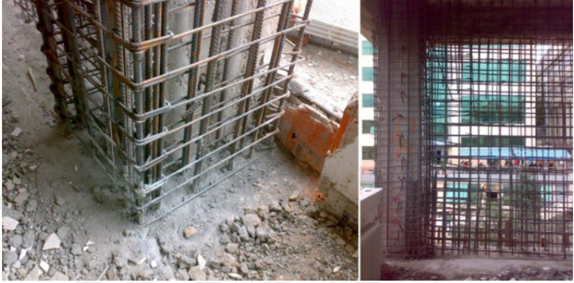
Şekil 2.3 Binadaki güçlendirme çalışması(Soyoz vd. 2013)
