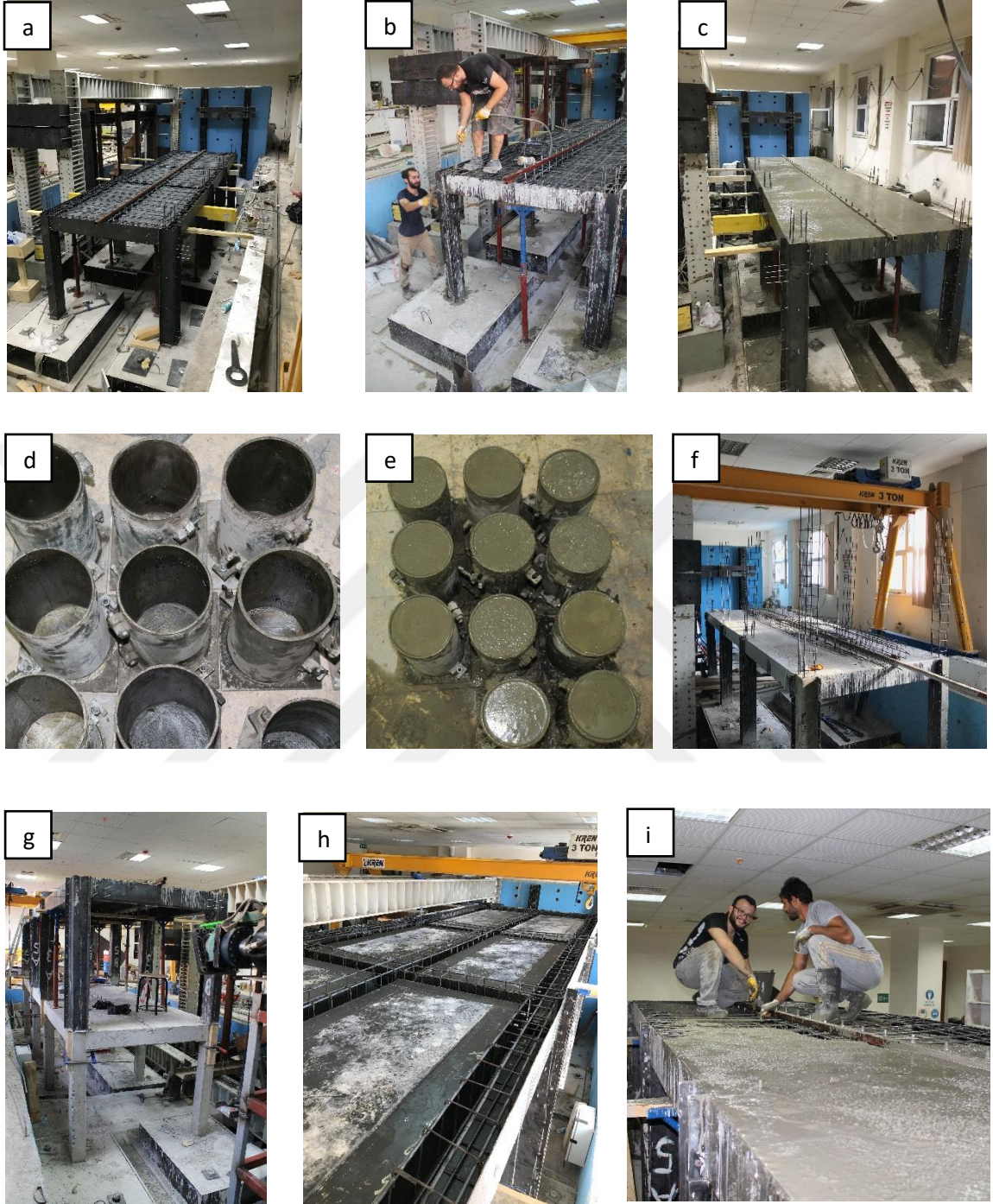
Şekil 3.14 Betonarme sistemin imalat evreleri a) Döşeme donatılarının yerleştirilmesi b) Beton dökümü esnasında uygulanan vibrasyon işlemi c) Birinci kat beton döküm işleminin tamamlanması d) Hazırlanan betondan numune almak için hazırlanan silindirik numune kalıpları e) Alınan numuneler f) İkinci kat kolon filizlerinin bağlanması g) İkinci kat kaplarının kurulması h) İkinci kat donatıları i) İkinci kat beton dökümü
