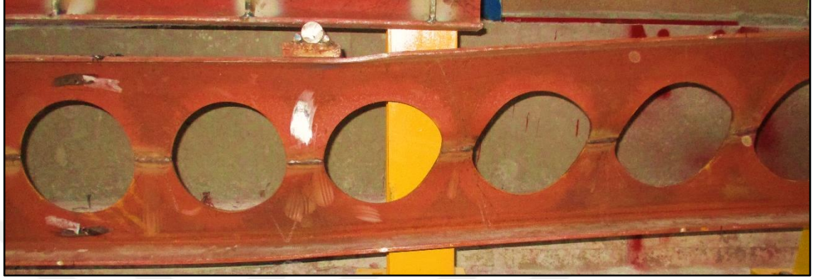
Şekil 4.78. IPE_DB_300_Test_2; iki noktadan yükleme altında göçme durumu
