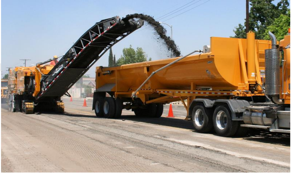
Şekil 2.8. Soğuk Düzeltme İşlemi ve Yol Yüzeyi (www.middleeast.com 2018)
