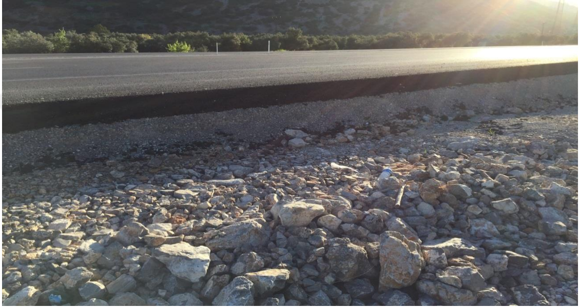
Şekil 2.6. Bitümlü Sıcak Karışım Tabakaları
