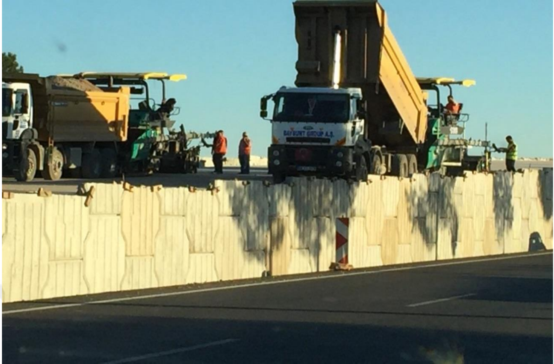
Şekil 2.7. Bitümlü Sıcak Karışımın Yola Finişerle Serilmesi İşlemi
