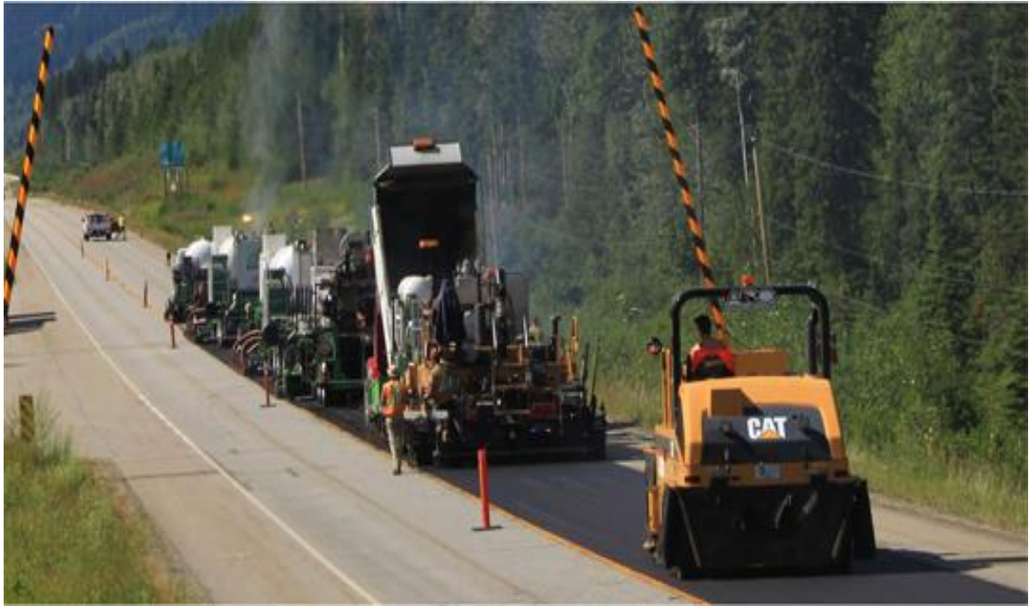
Şekil 2.9. Sıcak Yerinde Geri Dönüşüm (www.ecopavesystems.com 2018)
