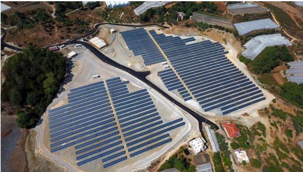
Şekil 2.22 Alanya Belediyesi’nin 3MW’lık Güneş Enerjisi Santrali
