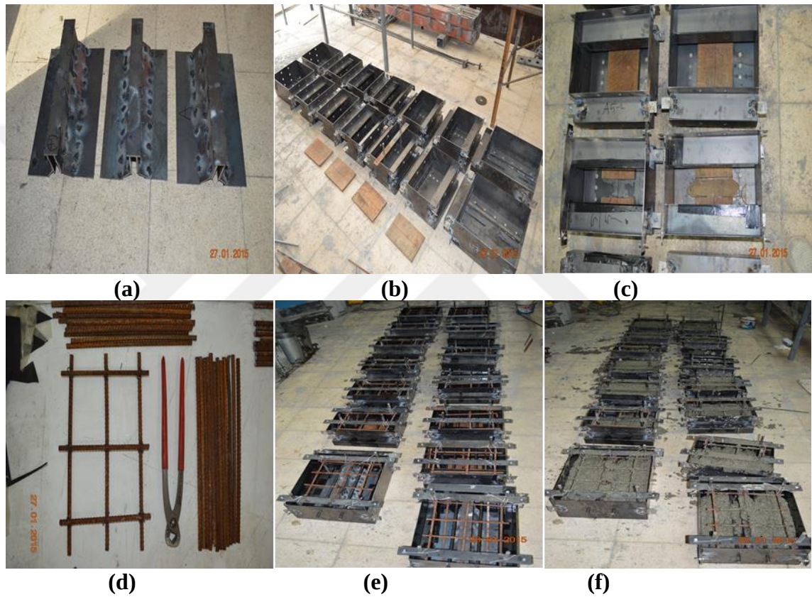
Şekil 3.17. a) Kızak imalatı; b) Kalıp imalatı; c) Suntalam plakaların kalıp içerisine yapıştırılması; d) Izgara imalatı; e) Izgaraların kalıp içerisine yerleştirilmesi; f) Beton dökümü (112M820 numaralı projeden alınmıştır)
