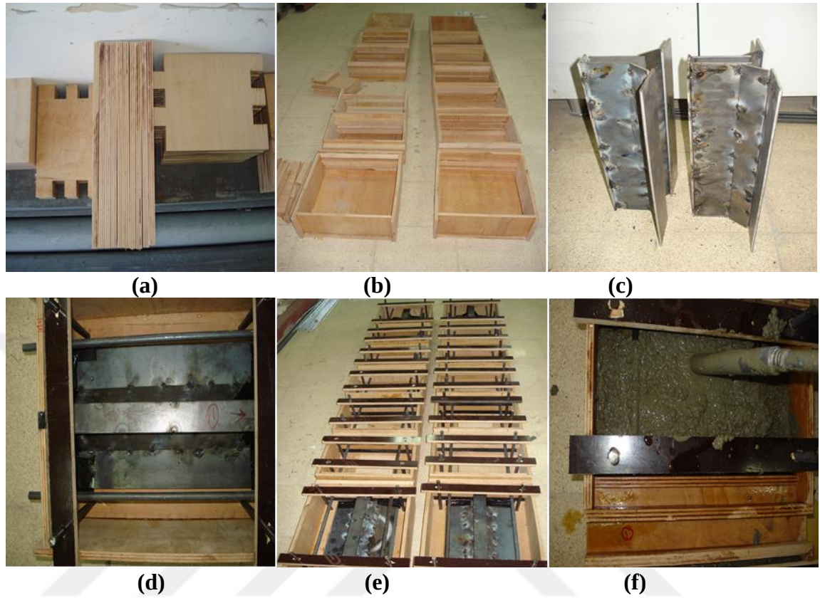
Şekil 3.14. a) Suntalam plakaların kesimi; b) Kalıp imalatı; c) Kızak imalatı; d) Kızakların kalıp içerisine yapıştırılması; e) Beton dökümü öncesi kalıplar; f) Beton dökümü (112M820 numaralı projeden alınmıştır)
