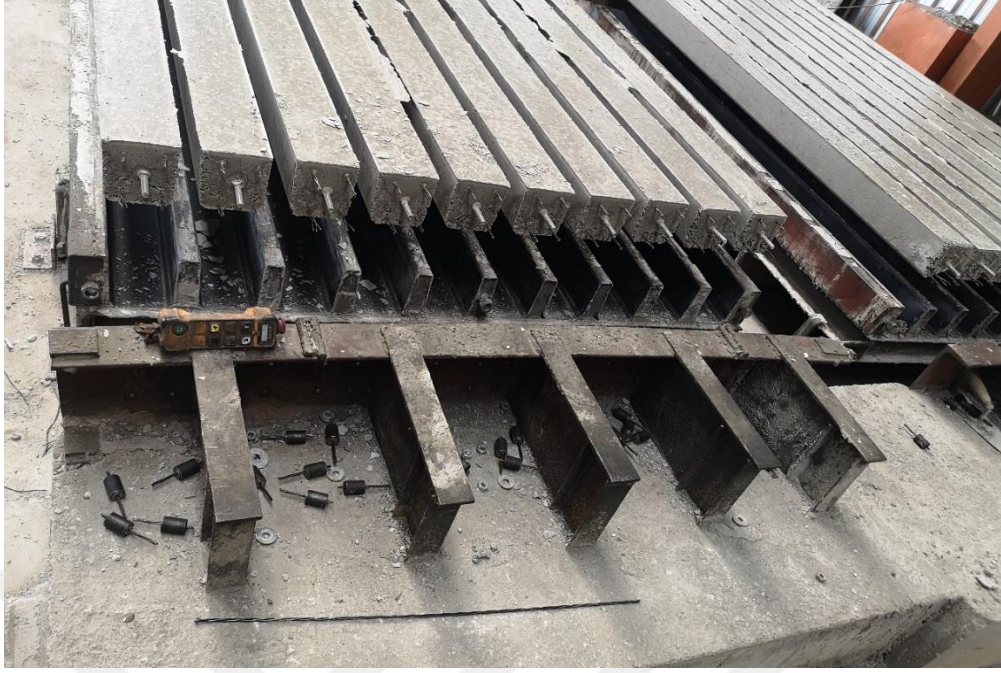
Şekil 3.21. Öngerilmeli beton kolonların kalıptan çıkarılması
