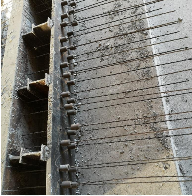
Şekil 3.9. Öngerme toronun ve kovanının kalıptaki yerleşimi
