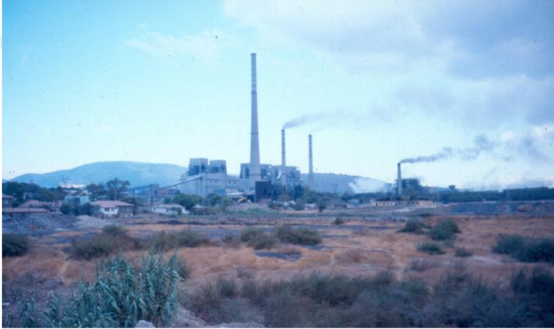
Şekil 2.1. Soma termik santralinden genel bir görünüm.
