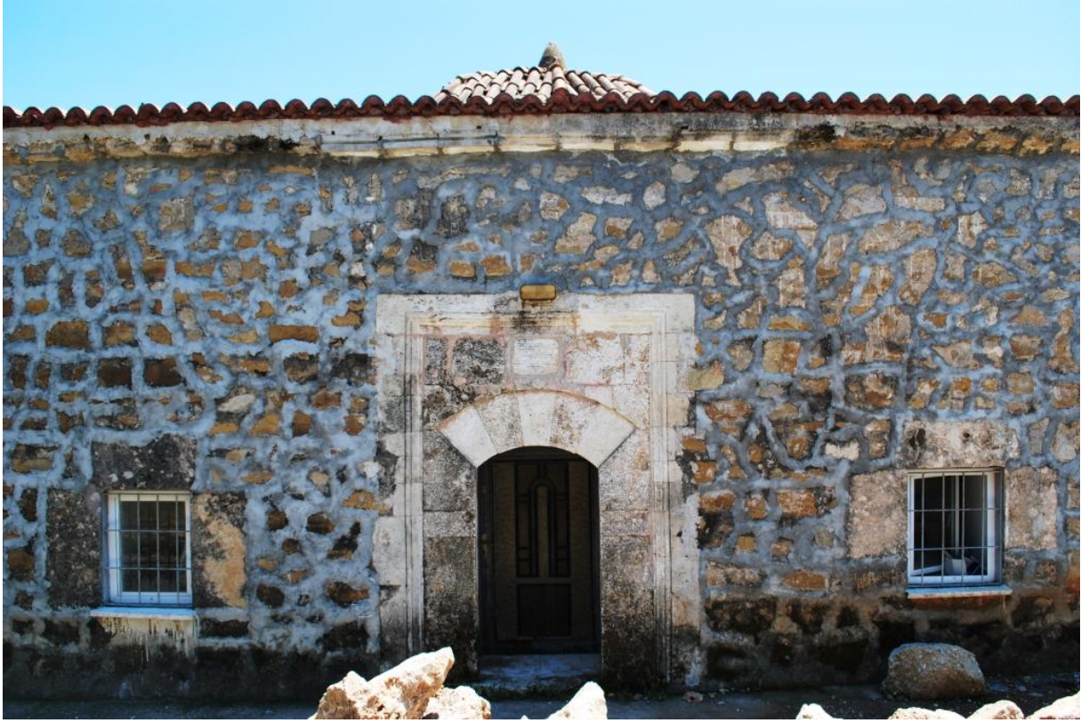
Fotoğraf 210: Hacı Hasan Ağa Mescidi'nin kuzey cephesi ve harime giriş kapısı
