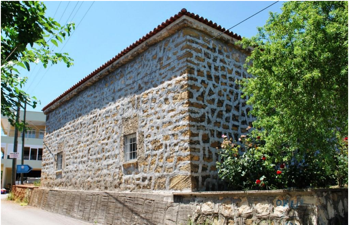
Fotoğraf 209: Hacı Hasan Ağa Mescidi'nin güney cephesi
