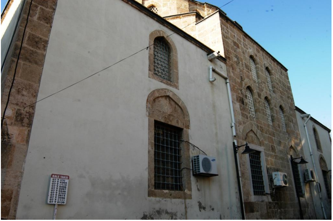
Fotoğraf 61: Tekeli Mehmet Paşa Cami güney cephe
