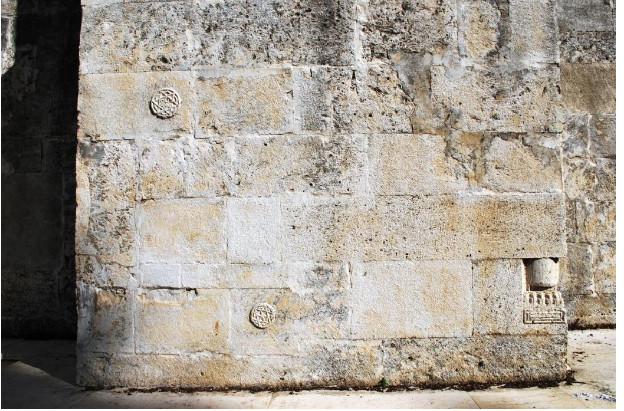
Fotoğraf 86: Ömer Paşa Camisi'nin güneybatı cephesinde yer alan taş süslemeler
