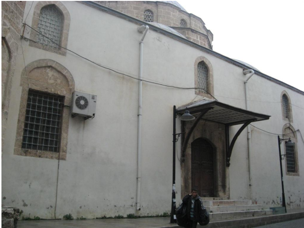
Fotoğraf 60: Tekeli Mehmet Paşa Camisi'nin batı cephesi
