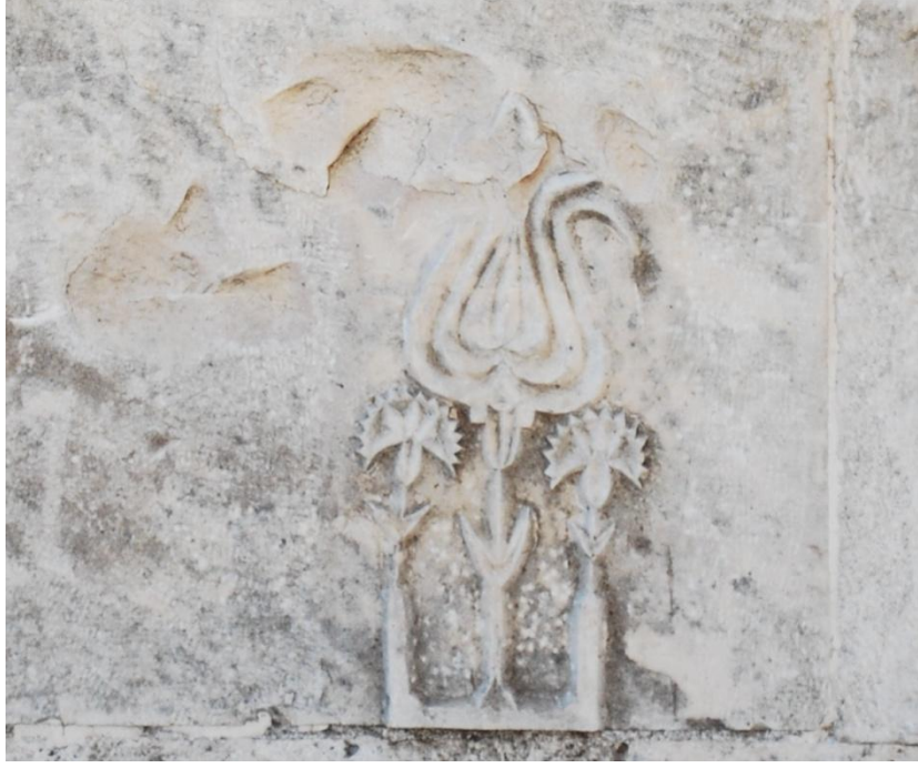
Fotoğraf 88: Ömer Paşa Camisi'nin güney batı cephedeki taş süslemelerden detay
