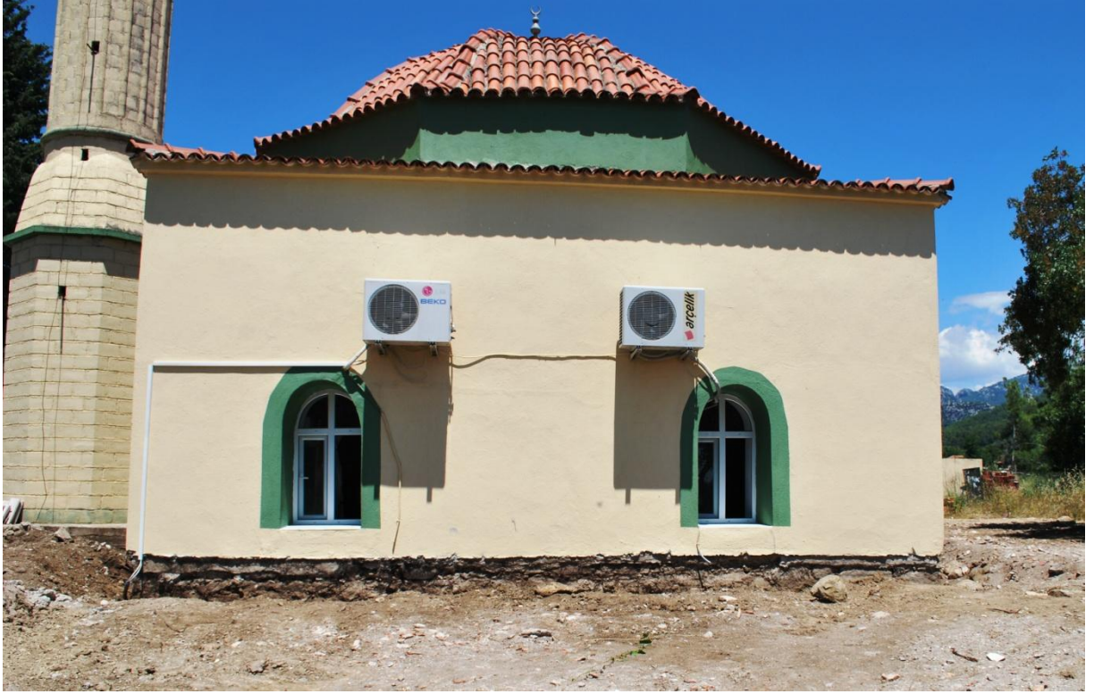
Fotoğraf 243: Alacami Mescidi'nin güney cephesi
