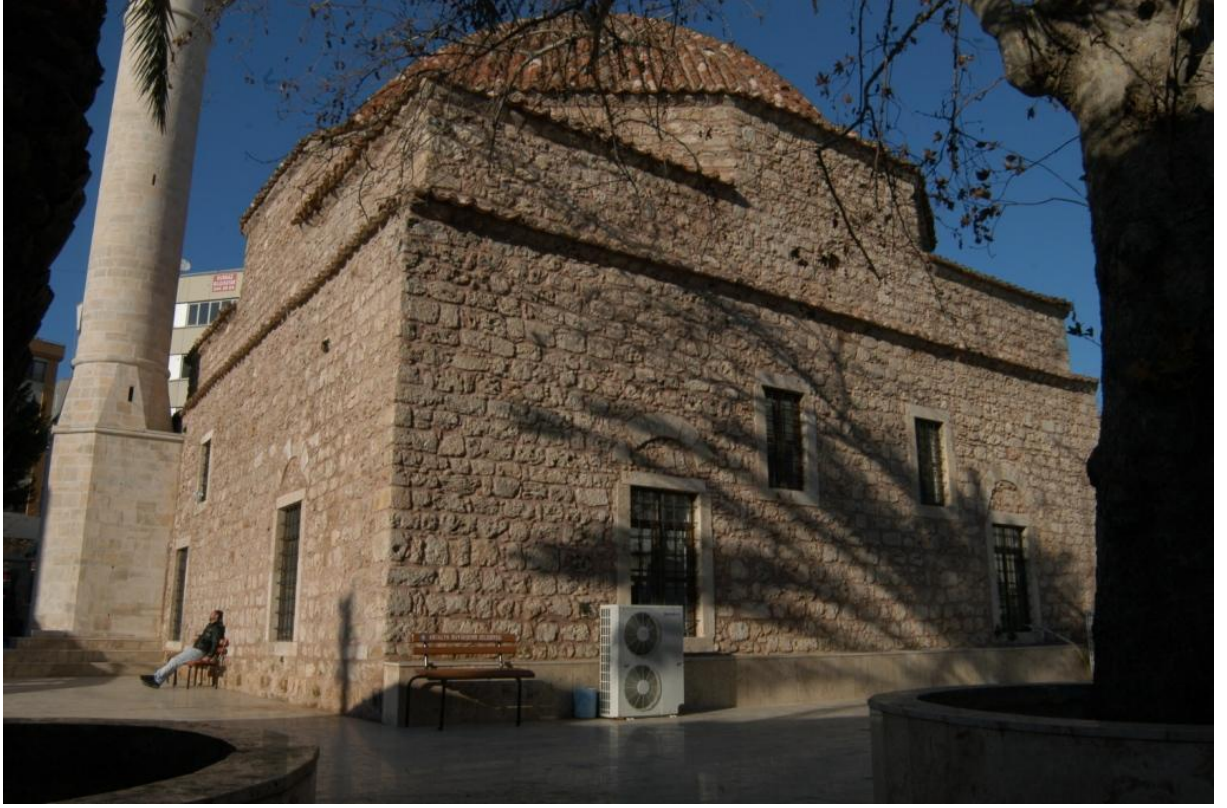
Fotoğraf 18: Bali Bey Camisi güneybatı cepheden görünüş
