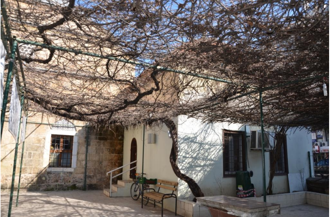
Fotoğraf 148: Müsellim Camisi'nin güneybatı köşesinde yer alan kütüphane odası
