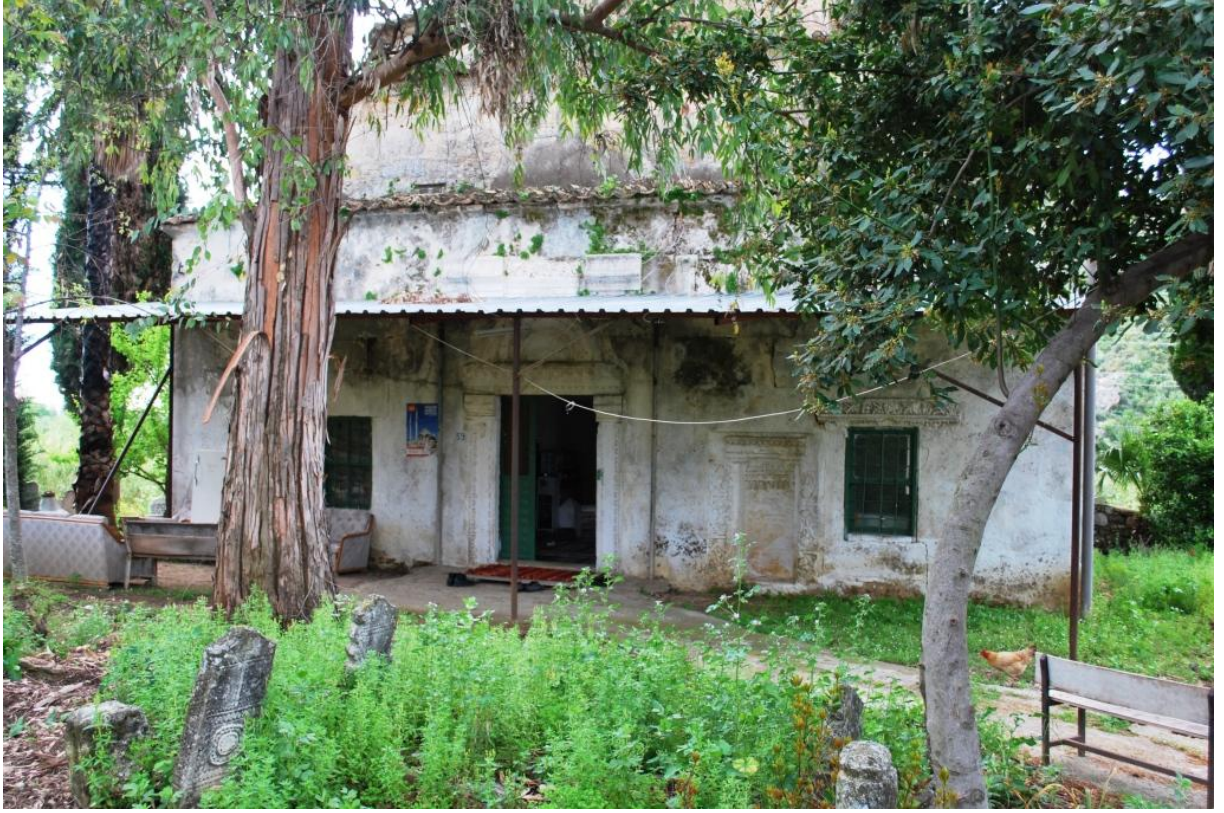
Fotoğraf 173: Ağalar Önü Mescidi'nin kuzey cepheden görünüşü
