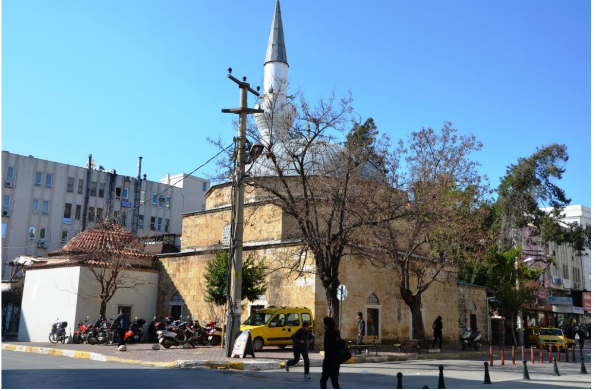
Fotoğraf 143: Müsellim Camisi'nin kuzeydoğu cepheden görünüşü
