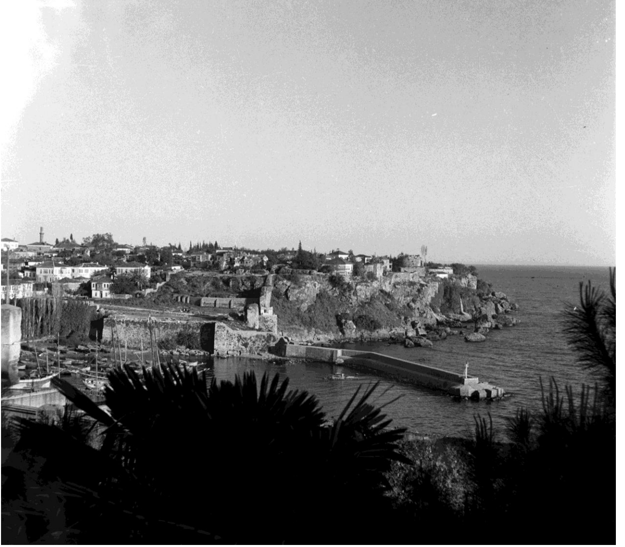
Resim 50 1950 Antalya İskelesi, Dalgakıran Onarımı Ardından, A.g.e.,33
