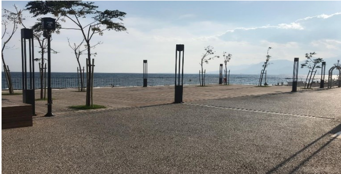
Şekil 5.4. Gölgeleme/korunma unsuru olmayan yürüme yolu ve seyir alanı
