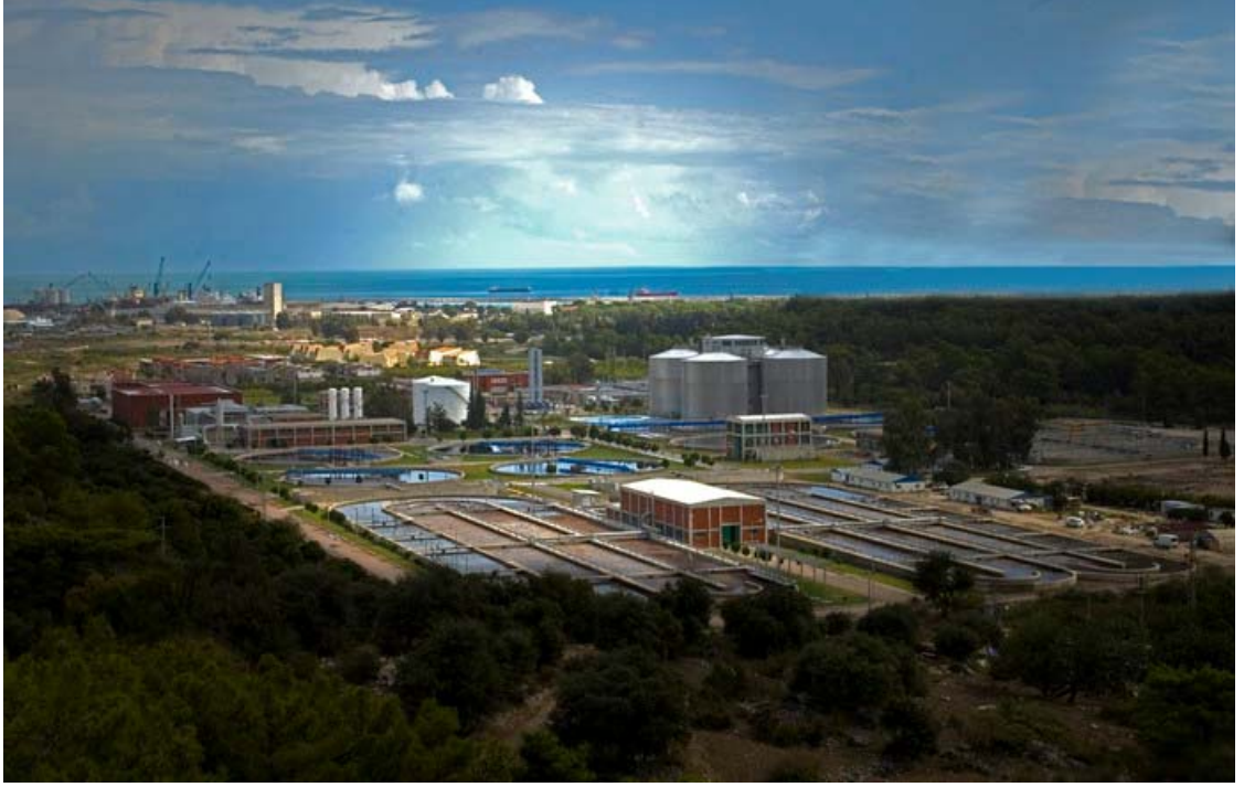
Şekil 3.1. Arıtma çamurunun elde edildiği Antalya Hurma İleri Atık Su Arıtma Tesisi
