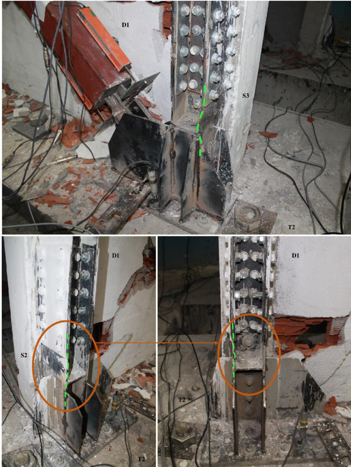
Şekil 4.30. Deney sırasında (%2.5 GKÖÖ'da) GDE-2'ye ait çelik çerçevelerde gözlenen hasarlar
