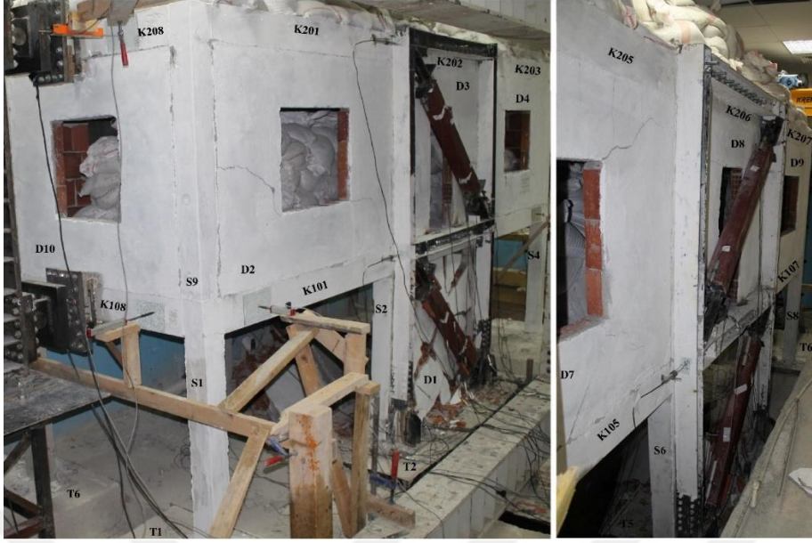
Şekil 4.33. Deney sırasında (%3.0 GKÖÖ'da) GDE-2'ye ait betonarme yapıda gözlenen hasarlar (3'üncü kısım)
