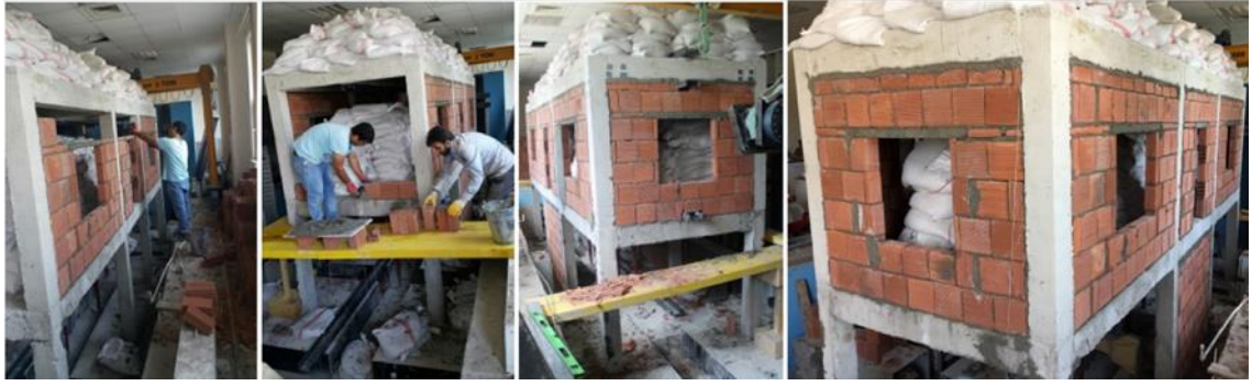
Şekil 3.20. Tuğla duvar örme işlemi
