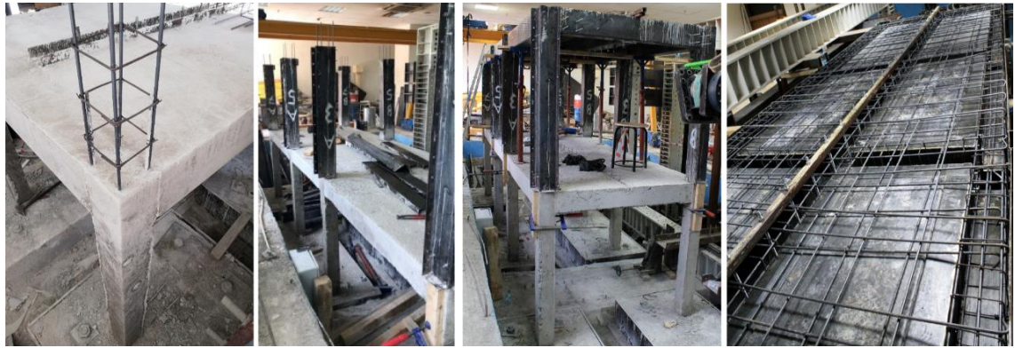
Şekil 3.15. İkinci kat kalıp kurulumu ve donatıların yerleştirilmesi
