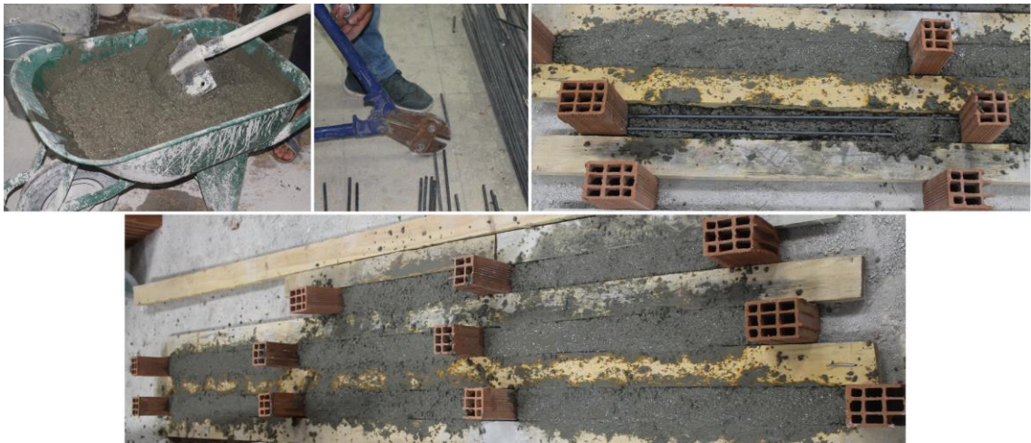
Şekil 3.19. Kapı pencere lentolarının hazırlanması
