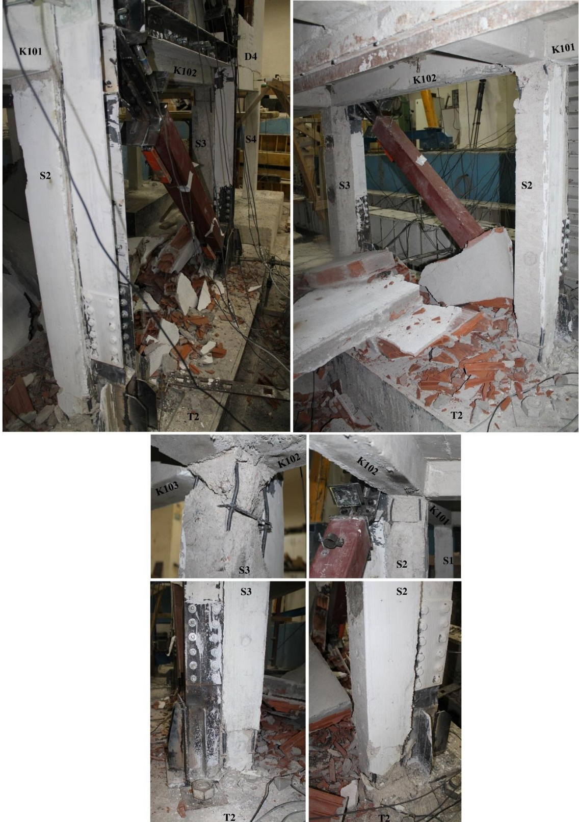
Şekil 4.35. Deney sırasında (%3.5 GKÖÖ'da) GDE-2'ye ait betonarme yapıda gözlenen hasarlar (1'inci kısım)
