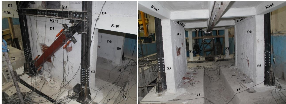
Şekil 4.44. Deney sırasında (%1.0 GKÖÖ'da) GDE-3'te gözlenen hasarlar (2'nci kısım)
