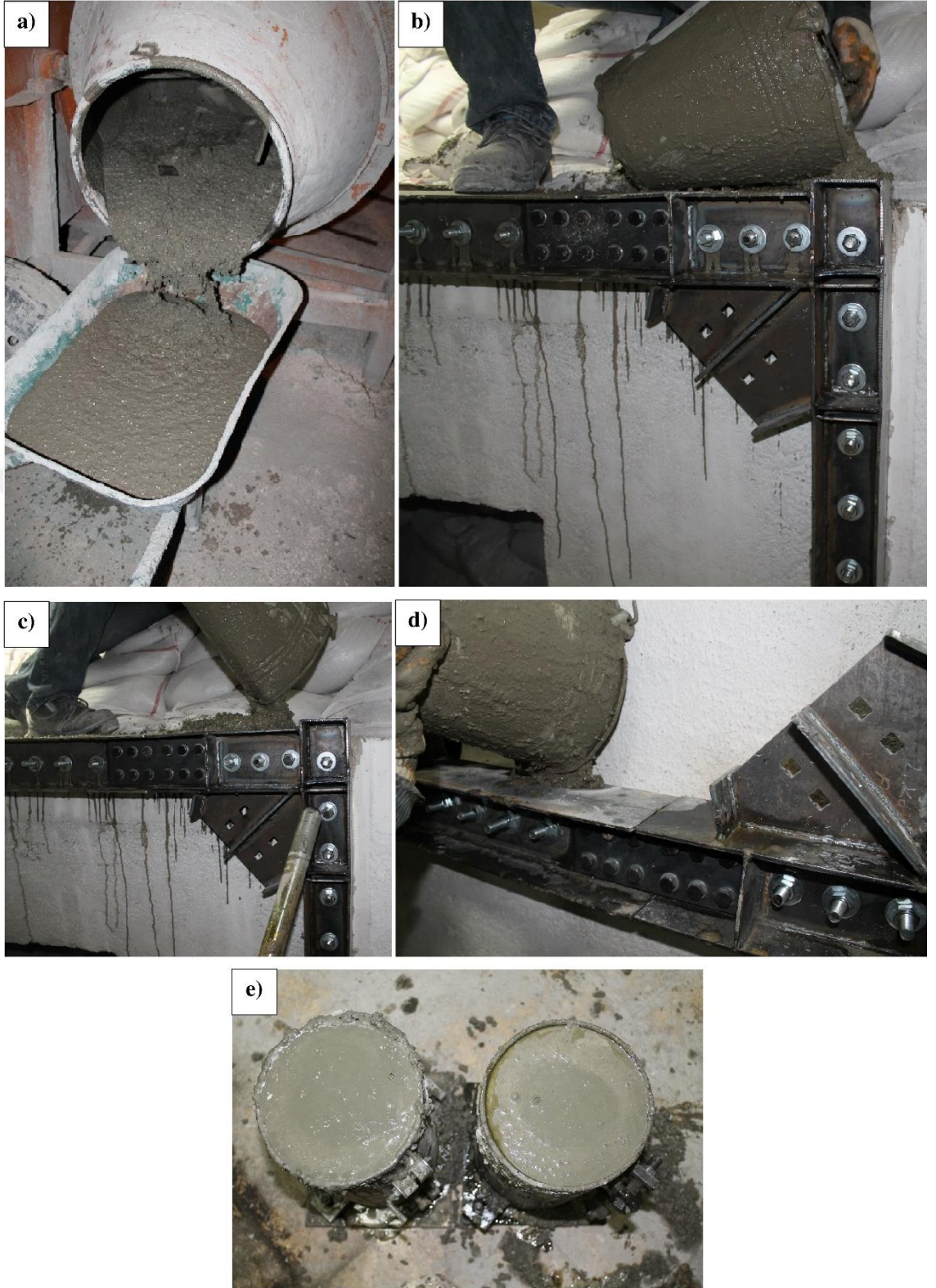
Şekil 3.30. Çelik çerçeveler ve betonarme çerçeve arasına beton dökülmesi a) mikserde betonun hazırlanması; b) kolonlar arası beton dökümü; c) ikinci kat kirişler arası beton dökümü; d) birinci kat kirişler arası beton dökümü; e) beton silindir numuneleri
