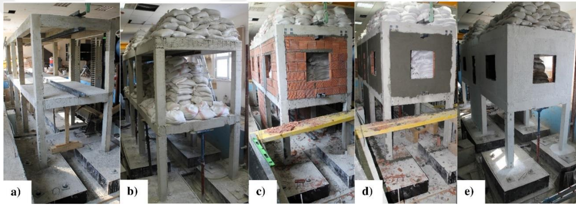
Şekil 3.6. RDE yapım aşamaları özeti a) kalıp sökülmesi sonrası; b) kum torbalarının yerleşimi sonrası; c) tuğla duvar örme işlemi sonrası; d) sıva işlemi sonrası; e) badana sonrası
