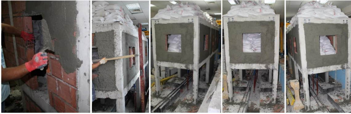
Şekil 3.21. Sıva işlemi
