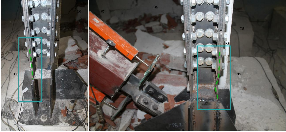
Şekil 4.51. Deney sırasında (%3.0 GKÖÖ'da) GDE-3'e ait çelik çerçevede gözlenen hasarlar
