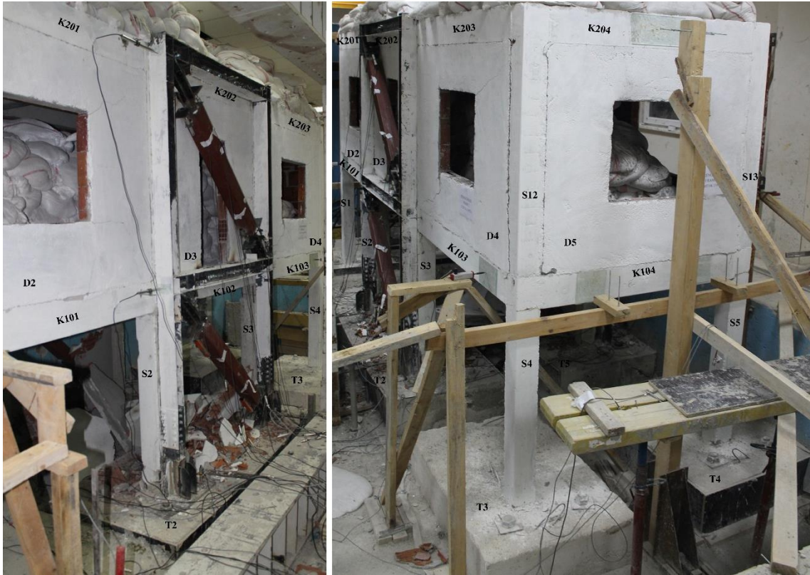
Şekil 4.37. Deney sırasında (%3.5 GKÖÖ'da) GDE-2'ye ait betonarme yapıda gözlenen hasarlar (3'üncü kısım)
