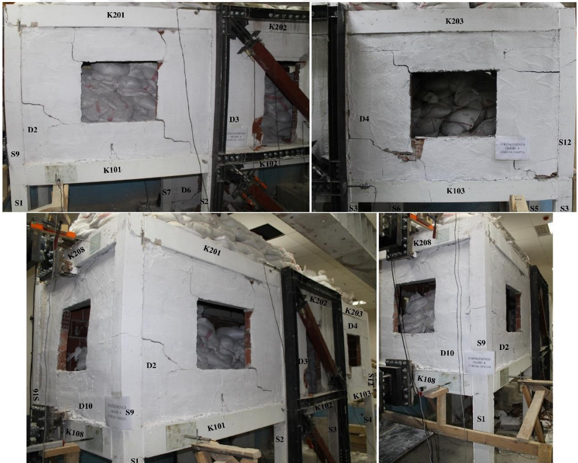
Şekil 4.50. Deney sırasında (%3.0 GKÖÖ'da) GDE-3'e ait betonarme yapıda gözlenen hasarlar
